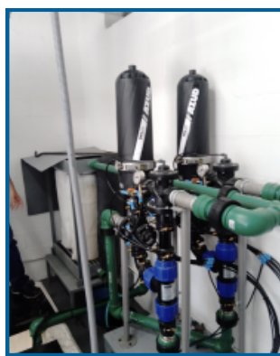
Fig. 2: Sistema de filtración por anillas
